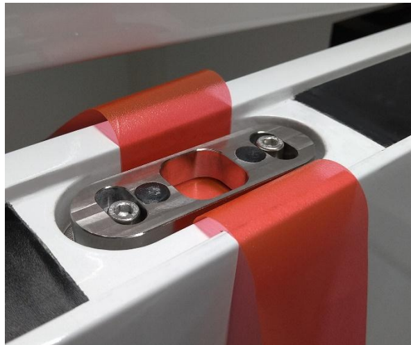
Abbildung 5: Schließblech inkl. Folie im Türblatt
